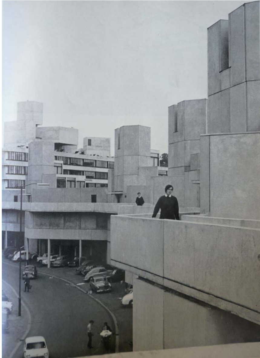
[F1] Fotografía desde la parte trasera de los zigurats residenciales mostrando los dos niveles de entrada con segregación circulatoria y los núcleos de escaleras sobresaliendo a modo de hitos y marcando las entradas. Architectural Design, mayo (1969)
