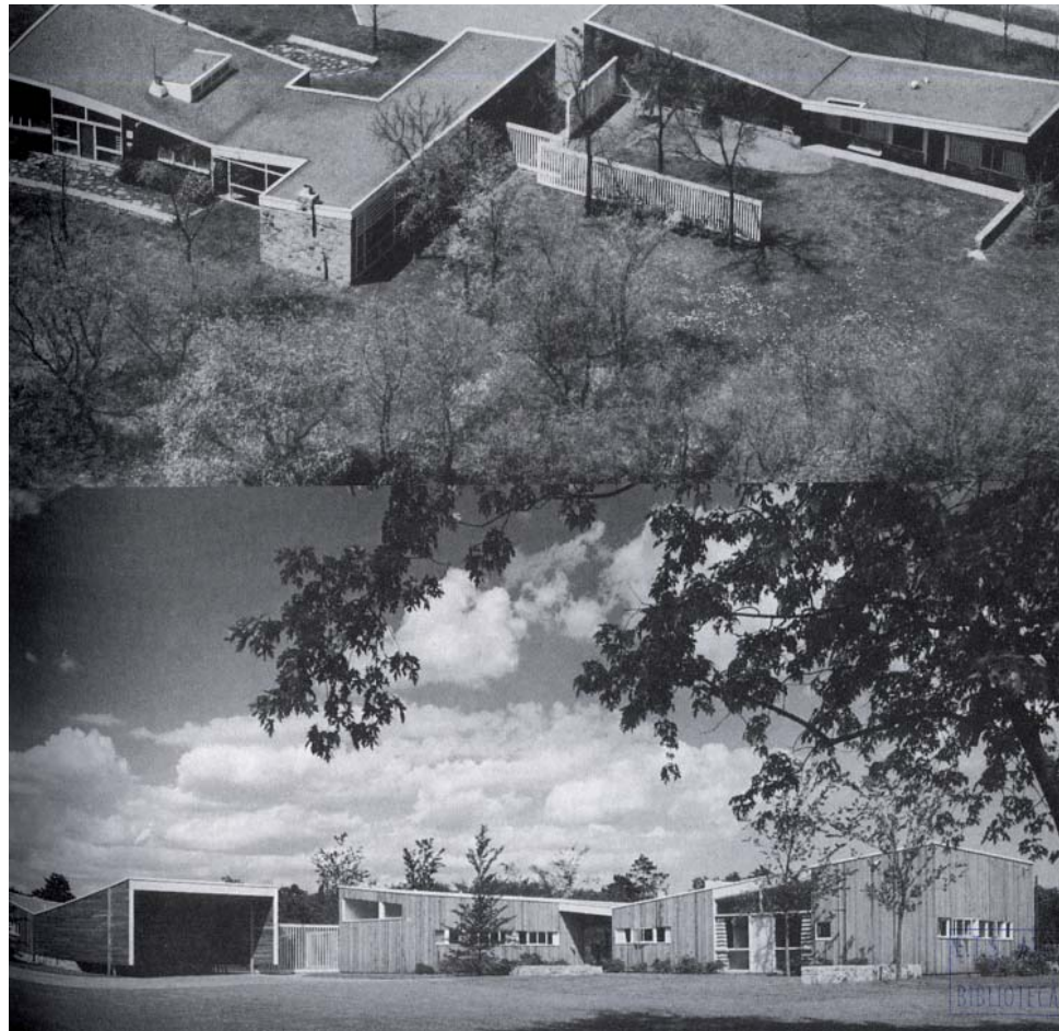
[F8] Marcel Breuer, casa Robinson, Williams-town(Massachussets), 1947. Extraído de Breuer Houses, Joaquim Driller. (Londres, Phaidon Press Ltd.2000).
