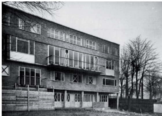
[F11] Fachada sur de Willow Road en construcción. Ernő Goldfinger. 1939. Londres. Foto: AR
