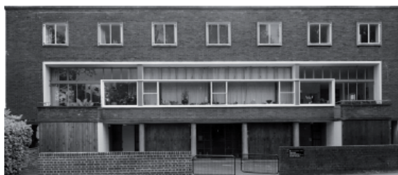
[F13] Alzado frontal de las viviendas de Willow Road. Ernő Goldfinger. 1939. Londres. Foto del autor.
