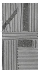
Se trabaja en la repetición con desplazamiento de una misma curva para crear volumen y movimiento en la fachada. Para ello se diseña una plantilla que servirá de guía de corte para todas las planchas. Como herramienta, el hilo caliente. La utilización de materiales de distinto espesor es intencionada, ya que las planchas de 1,5 cm de espesor dejarán en la pieza hendiduras profundas en sombra que independizarán una curva de otra.
