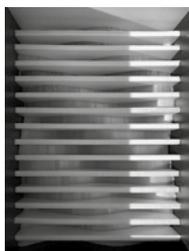
El concepto de tejido sugiere la continuidad del material. En este caso, el trabajo sobre el hormigón como fibra se ha conseguido en algunas zonas de la pieza. La complejidad de la misma abocó a un estudio previo en 3D y a su ejecución con ayuda de la fresadora para el corte de las planchas. A la vez, la esbeltez requerida se solventó con piezas de muy poco espesor, riesgo que provocó algunas fracturas en la pieza final.
