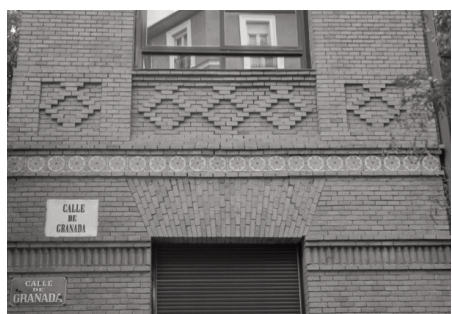
Estudio de Laurent. Detalles de la fachada de ladrillo
