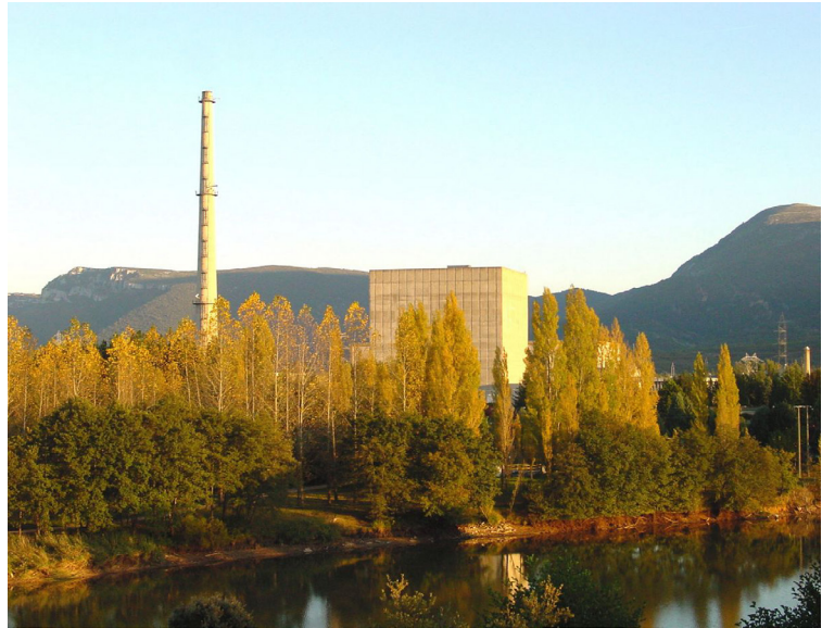
Figura 12. CN Santa María de Garoña. Fotografía desde la carretera (2016). Fuente: Archivo Nuclenor.
