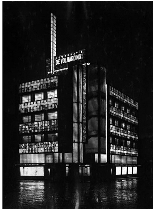
Figura 8. Arthur Körn: fotografías diurna y nocturna del edificio de oficinas de la cooperativa 'De Volharding' (La Haya, 1927-28), obra Jan Buijs y Joan B. Lürsen, publicadas en Glas im Bau und als Begrauchsgegenstand . (Fuente: Körn 1929).
