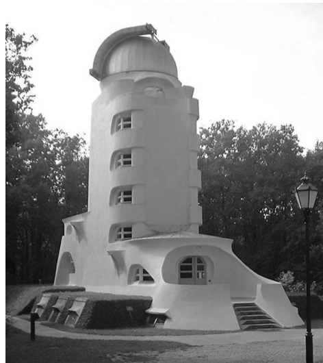
E. Mendelsohn, Torre Einstein, Potsdam, 1920. Arriba. Estado actual (Ref. web 5) Abajo. Planos originales. (Ref. web 6)
