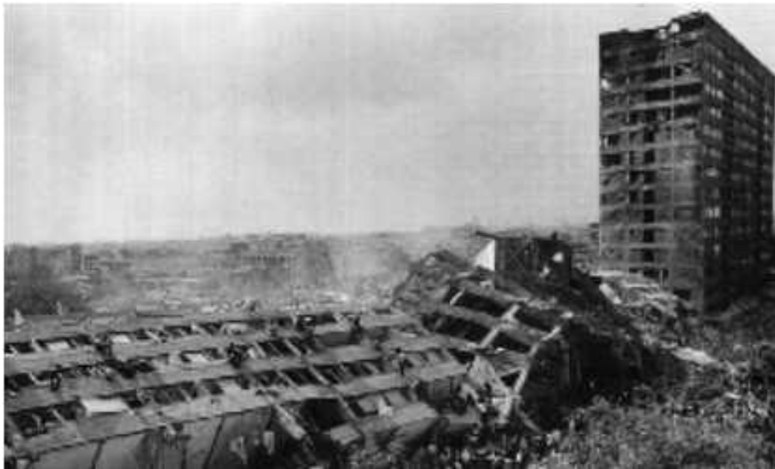
Figura 2. Edificio Nuevo León en Nonoalco-Tlatelolco, después del sismo de septiembre de 1985. Fotografía de Marco Antonio Cruz/ Imagen Latina. Tomado de: García Canclini, Castellanos y Rosas Mantecón (1996, 53).
