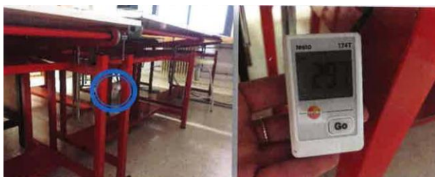
Fig. 5. Sonda temperatura de altura intermedia colocada en aula.
