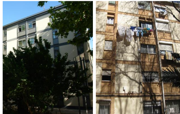
Fig. 4. Imagen de los edificios estudiados. Fachadas sur. Rehabilitado (izquierda) y original (derecha).
