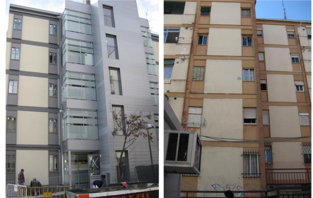
Fig. 3. Imagen de los edificios estudiados. Fachadas norte. Rehabilitado (izquierda) y original (derecha).
