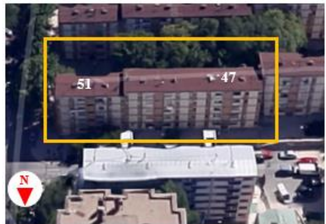
Fig. 1. Imagen del edificio estudiado. Portales número 51 (Rehabilitado) y 47.
