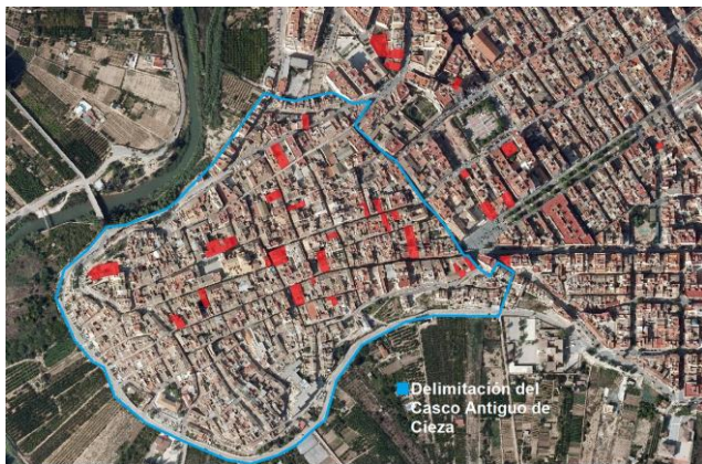
Fig. 5. Situación de los inmuebles en el municipio de Cieza.
