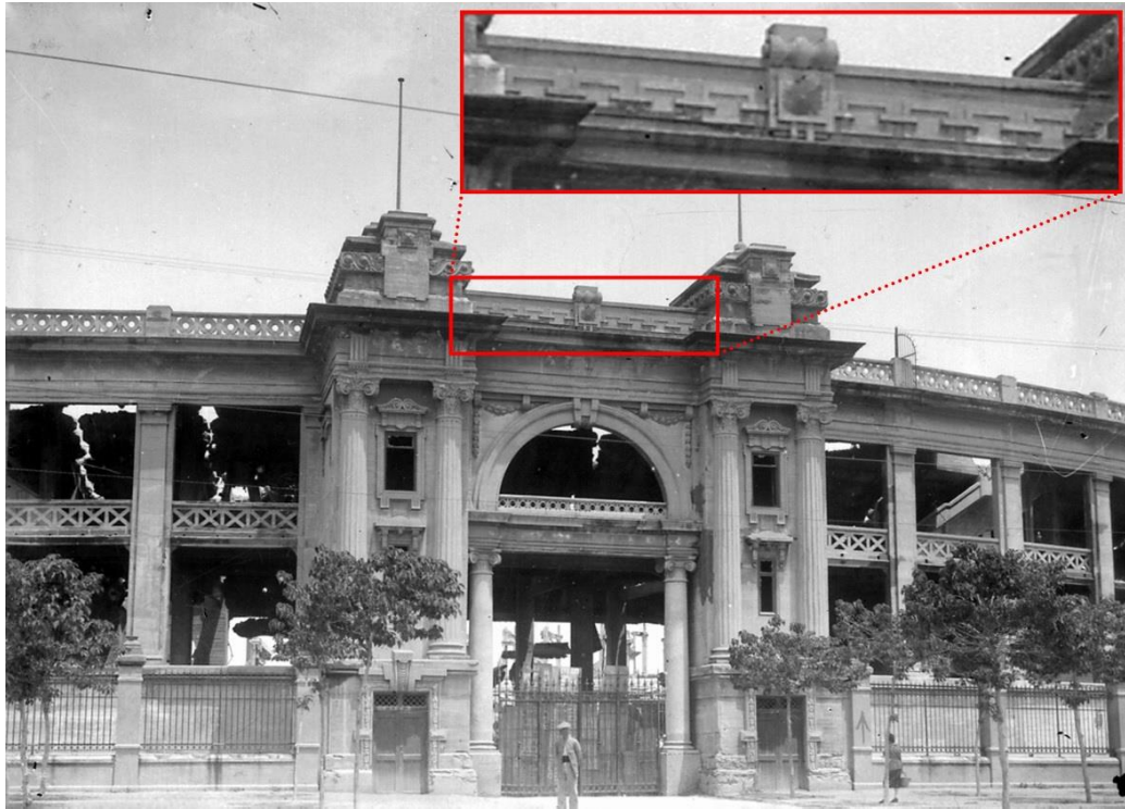
Fig. 15. Juan José Serrano. Trabajos de demolición de la plaza de toros Monumental. Vista exterior. Abril de 1930. ©ICAS-SAHP, Fototeca Municipal de Sevilla, Archivo Serrano.
