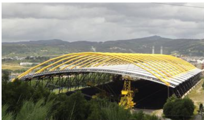
Fig. 1. Vista general de la cubierta (fuente: Acciona Ingeniería S.A.).
