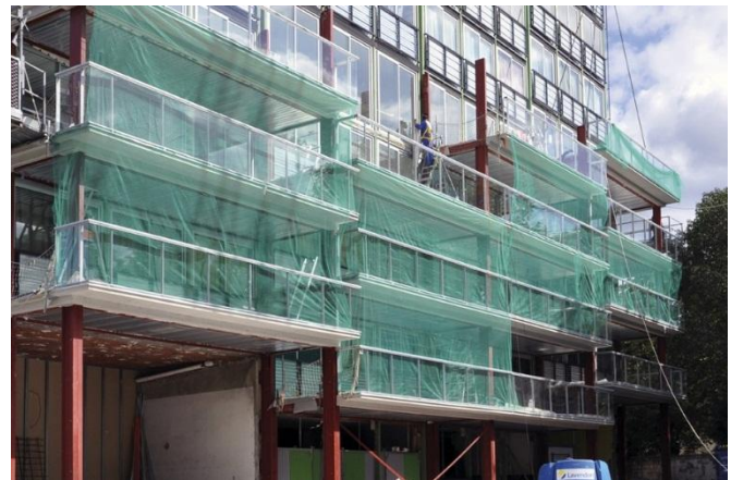
Fig. 5. Installation of tridimensional modules on Tour Bois-Le-Prêtre, Paris.
