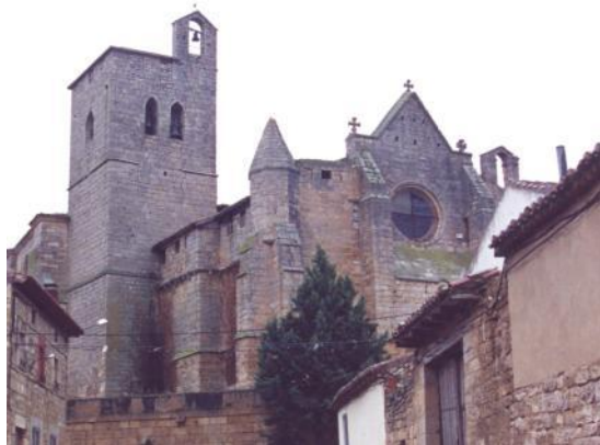
Fig. 4. San Esteban de los Balbases. Fachada principal, antes de la intervención altozano (fig. 4). En el lado septentrional se eleva una recia torre.
