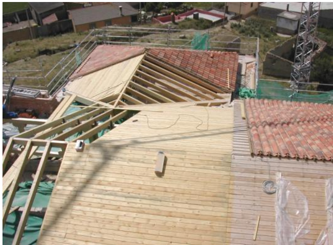
Fig. 8. San Esteban de los Balbases. Ejecución de las cubiertas.
