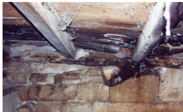
Fig. 7. San Esteban de los Balbases. Vista de las cubiertas desde la torre. Pudriciones generalizadas de la estructura de madera.
