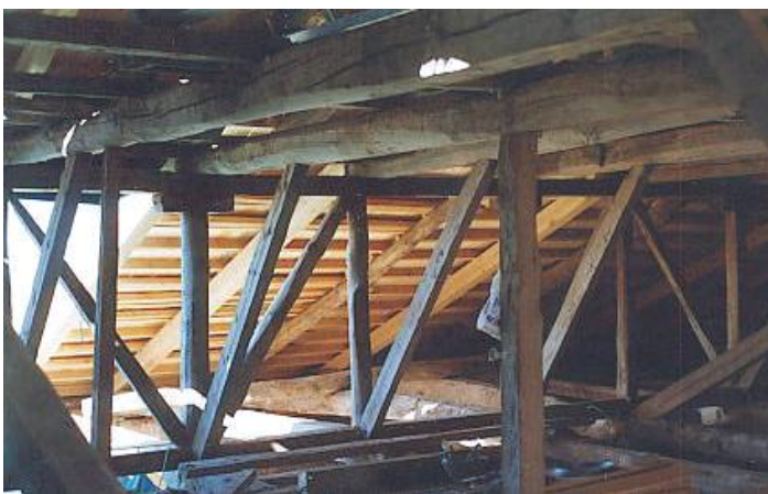
Fig. 9. Colegiata de Roa. Ejecución de las cubiertas.
