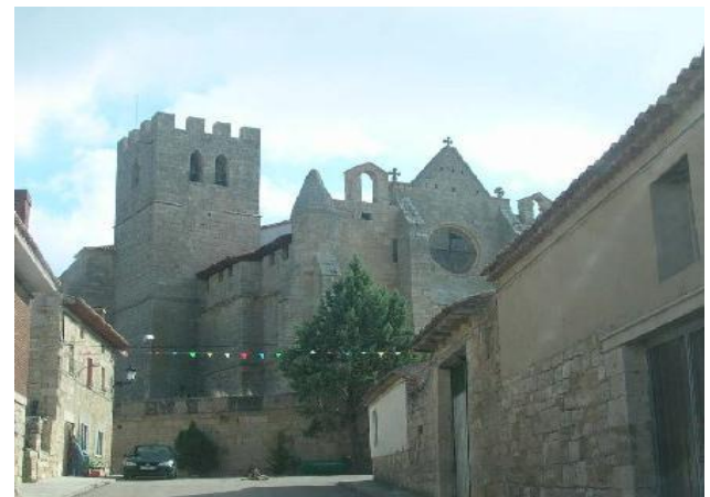
Fig. 11. San Esteban de los Balbases. Estado final.
